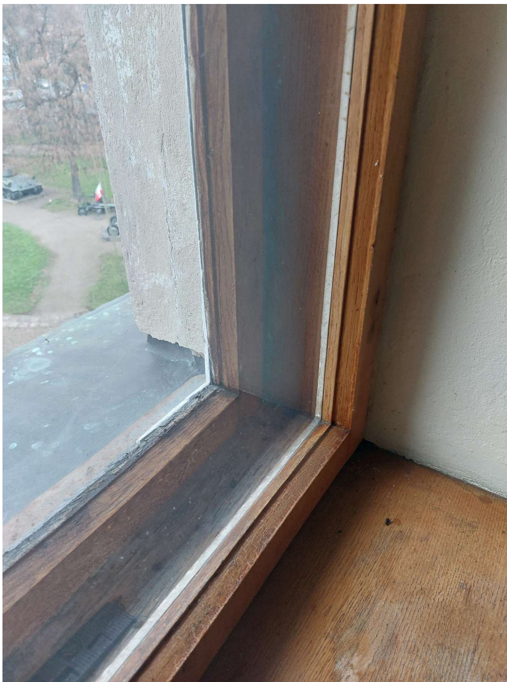
Okno na poddaszu przeznaczone do wymiany na okno oddymiające
