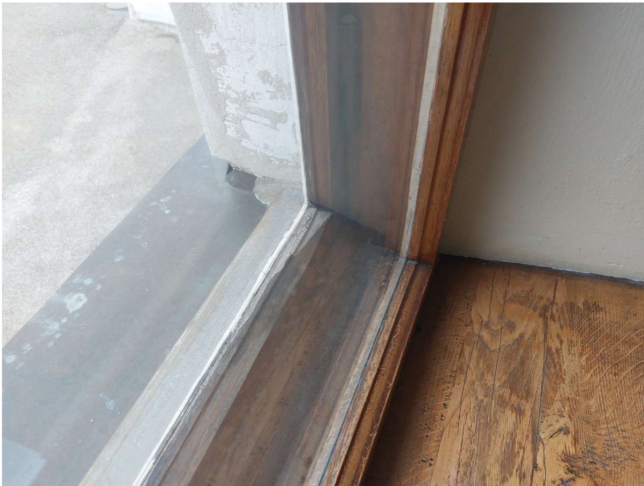
Okno na 2 piętrze przeznaczone do wymiany na okno oddymiające
