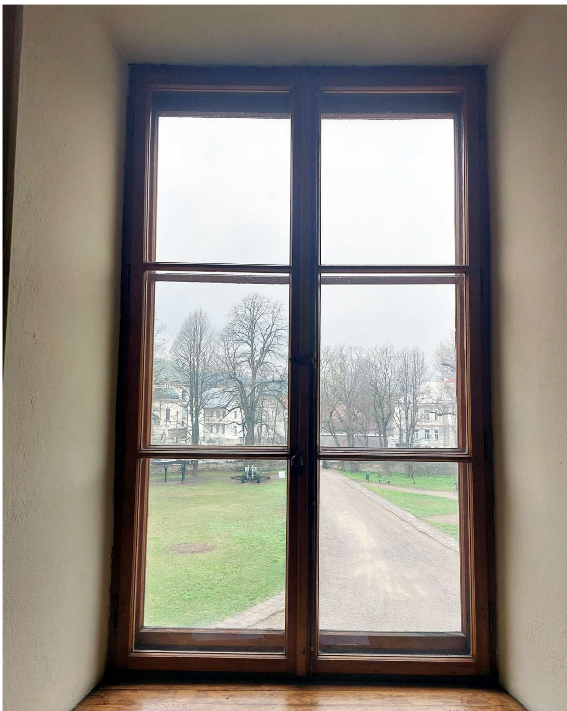
Okno na 2 piętrze przeznaczone do wymiany na okno oddymiające
